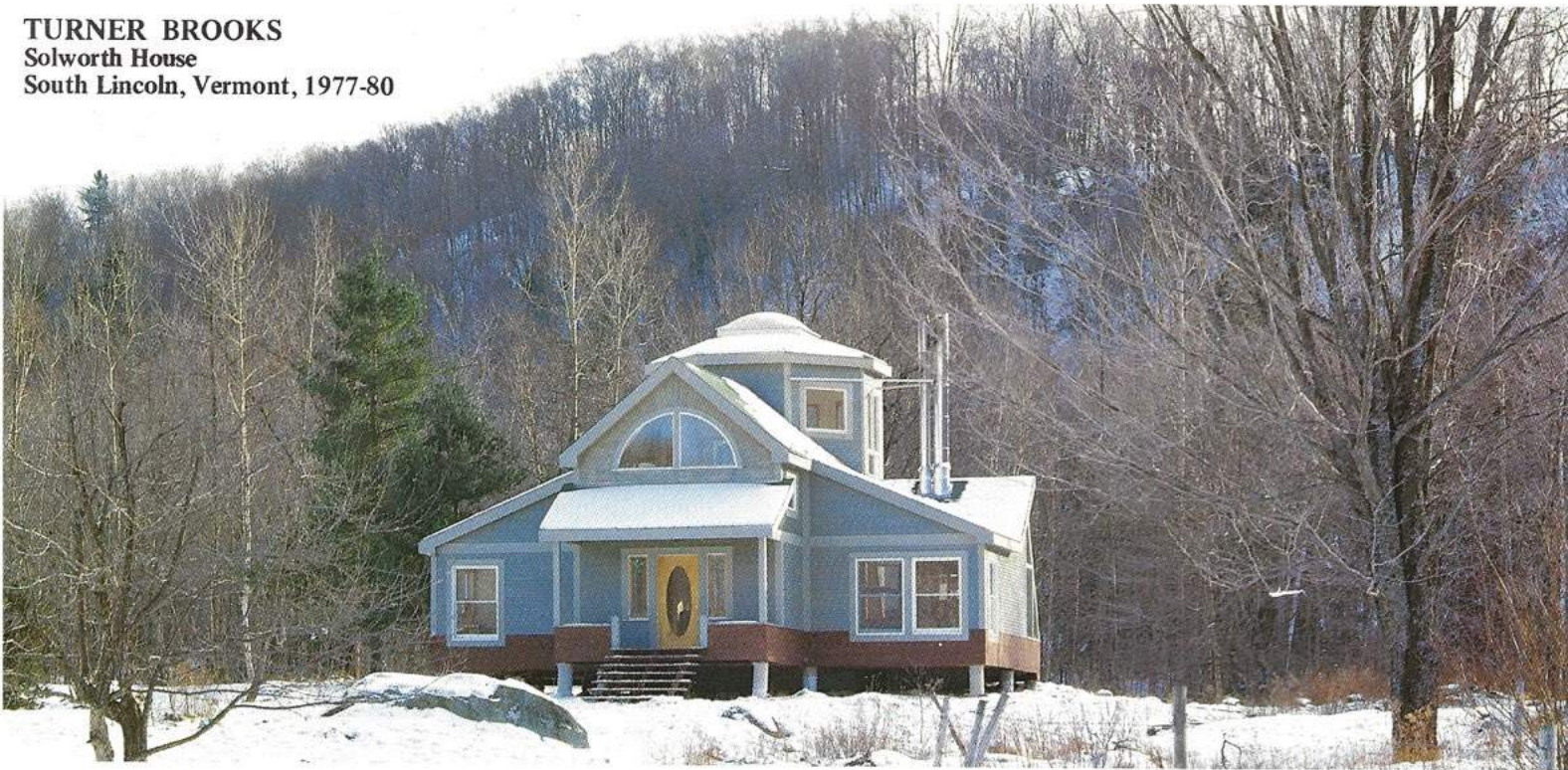
北より見る View from north
